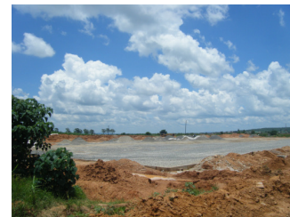
Het nieuwe kunstgrasveld in aanleg
